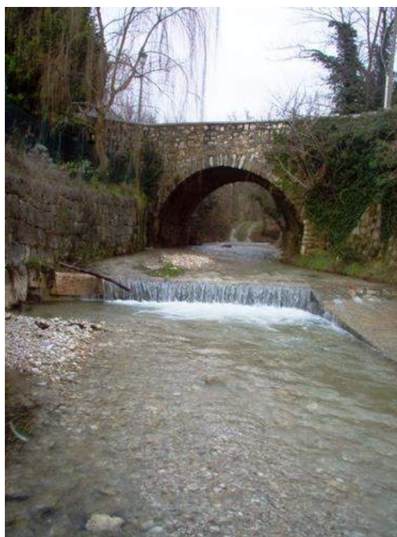
Figura 30 Ponte sul Torrente Tasso
