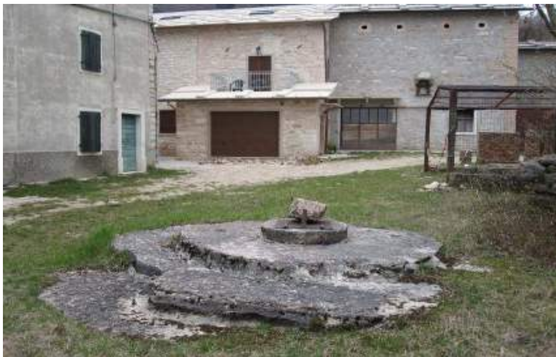
Figura 64 Cisterna contrada Mannarini di Erbezzo
