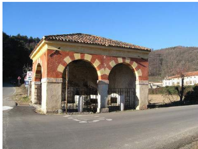
Figura 70 - Lavatoio loc. Marzemigo di Tregnago
