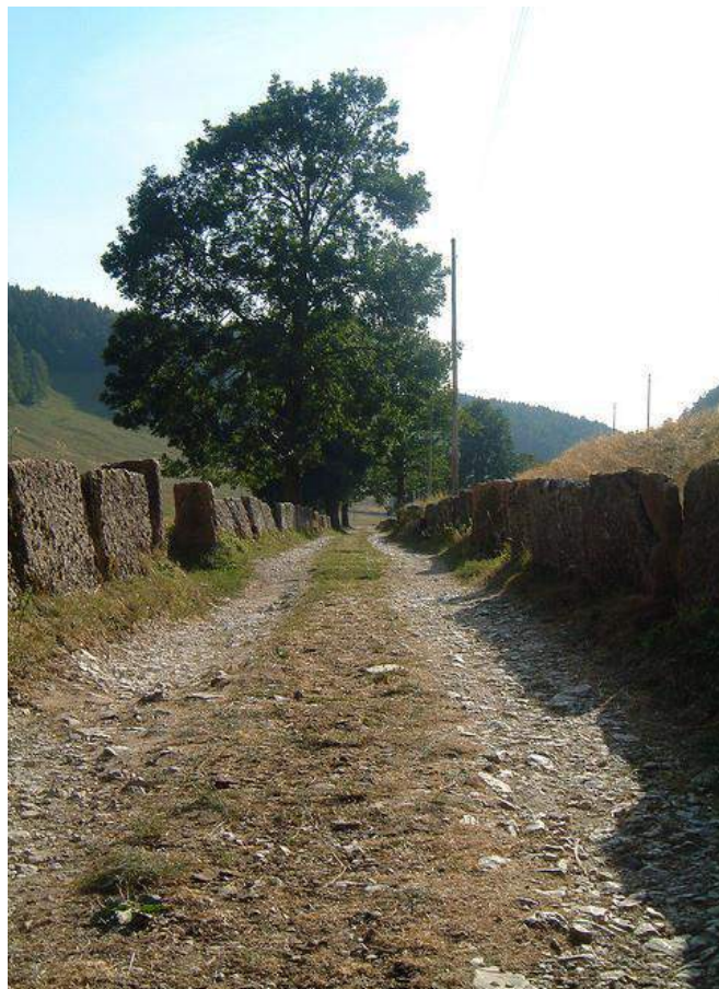
Figura 46 Strada delimitata da "laste"
