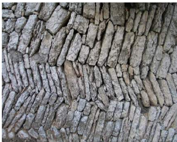
Figura 39 - Muro a spina di pesce
