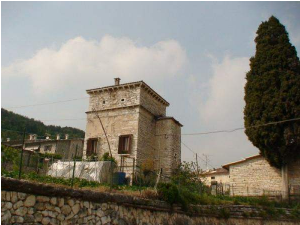
Figura 124 Torre Colombara a Prun
