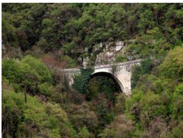
Figura 28 Ponte di Stallavena
