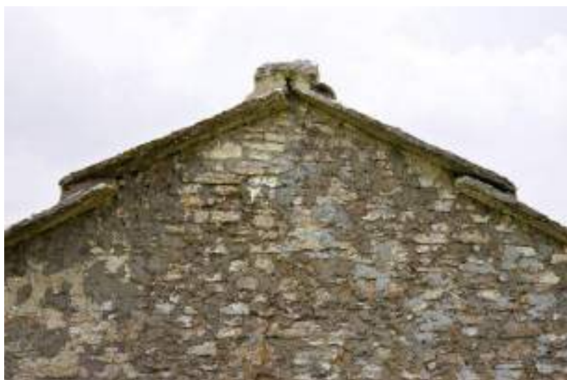
Figura 107 particolare del colmo tetto in pietra
