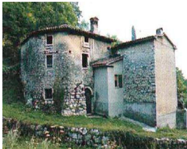
Figura 78 Maglio idraulico di Vilmezzano
